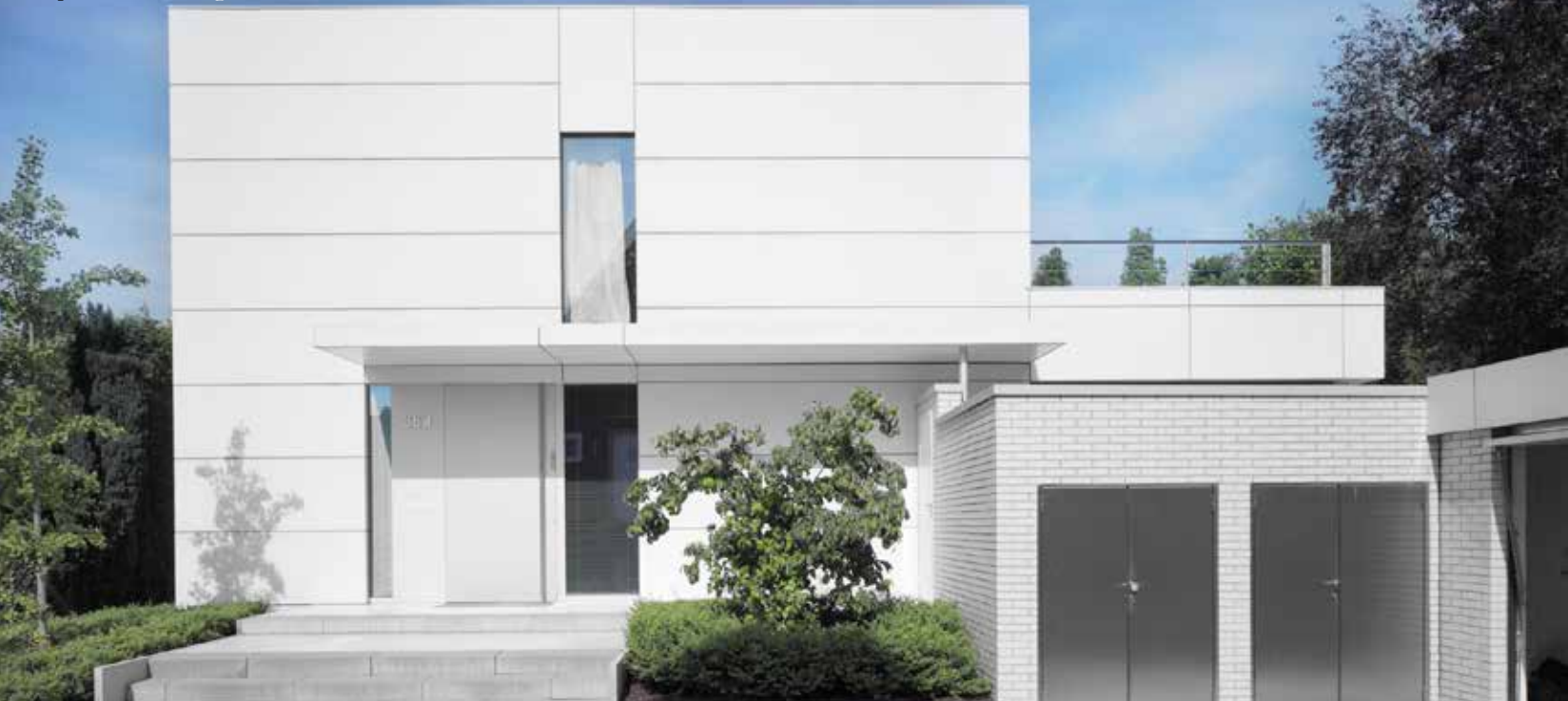
Einfamilienhaus in Münster
